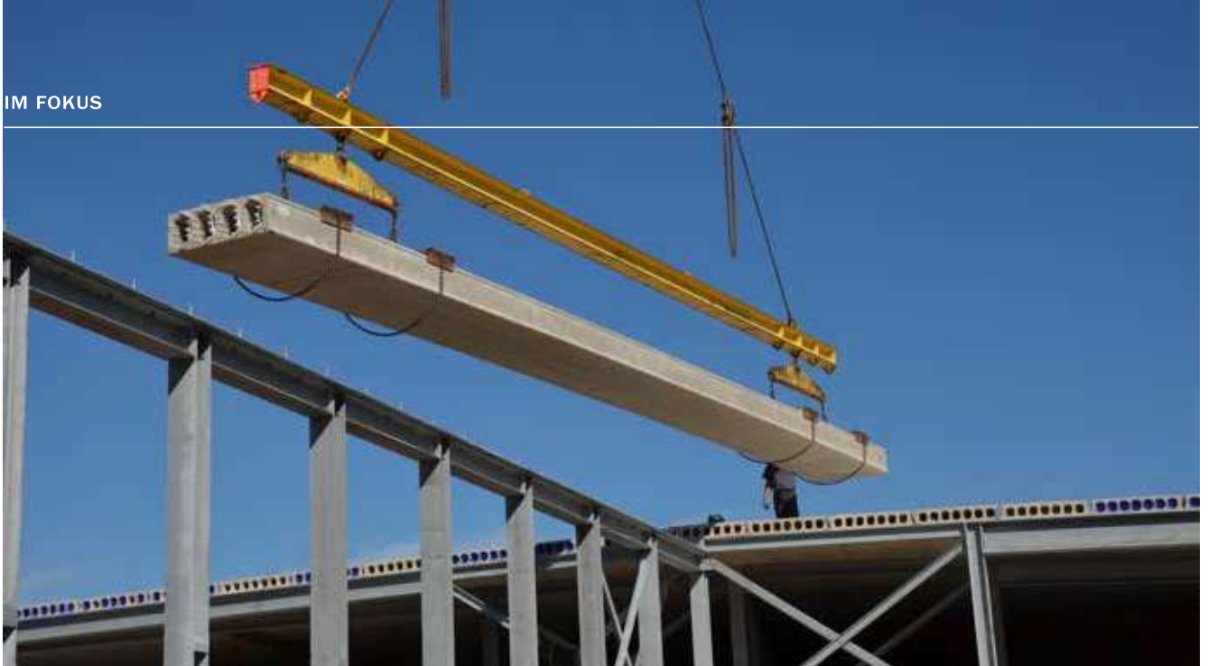
515 Stellplätze, 14 Splitlevel, 7 Geschosse: Die DW Systembau verbaute über 12.800 qm Hohlkammerdeckenplatten mit 40 cm Stärke und rund 824 qm Deckenplatten mit 26 cm Stärke.
